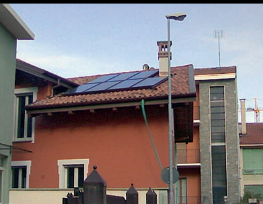
LA STRUTTURA. La villa di Settimo Torinese (To) oggetto della ristrutturazione
