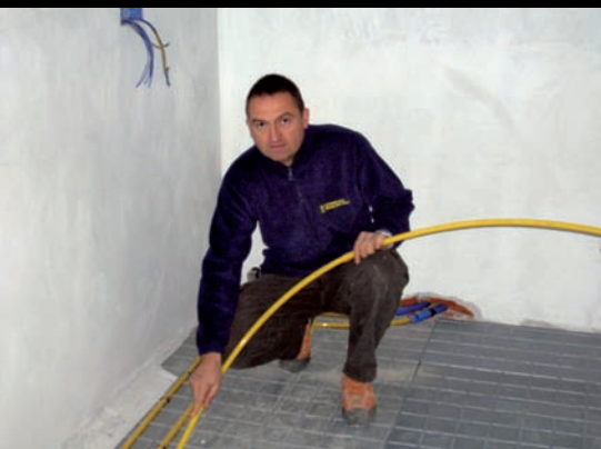
LA POSA DEL TUBO. L'installazione del tubo PE-Xb in polietilene ad alta densità
